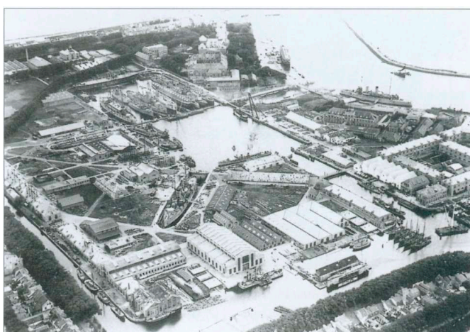
luchtfoto Rijkswerf Willemsoord
